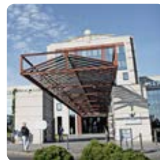
SIG Energieservices | CH
