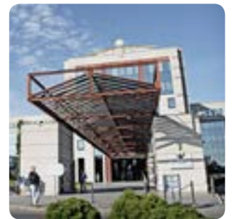
SIG Energieservices | CH
